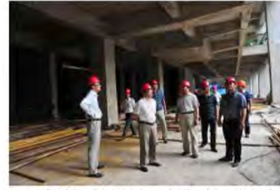
院领导视察新门诊住院综合楼工程建设情况并召开现场办公会。
